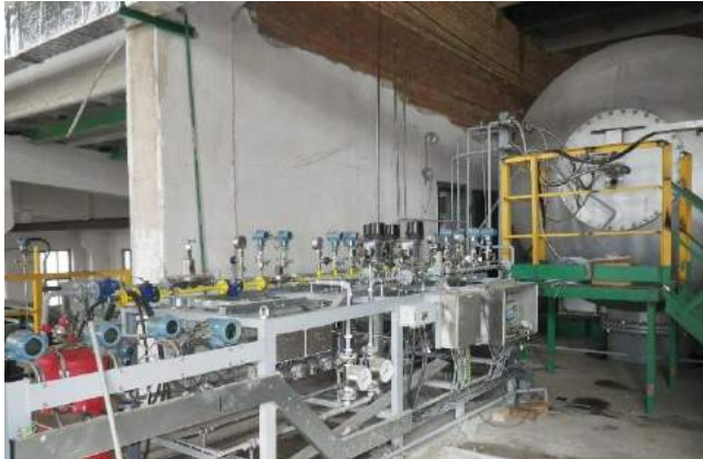
Генератор горячего газа для технологического газа (120.000 кг/ч) с температурой 700°C, НПЗ, Россия
